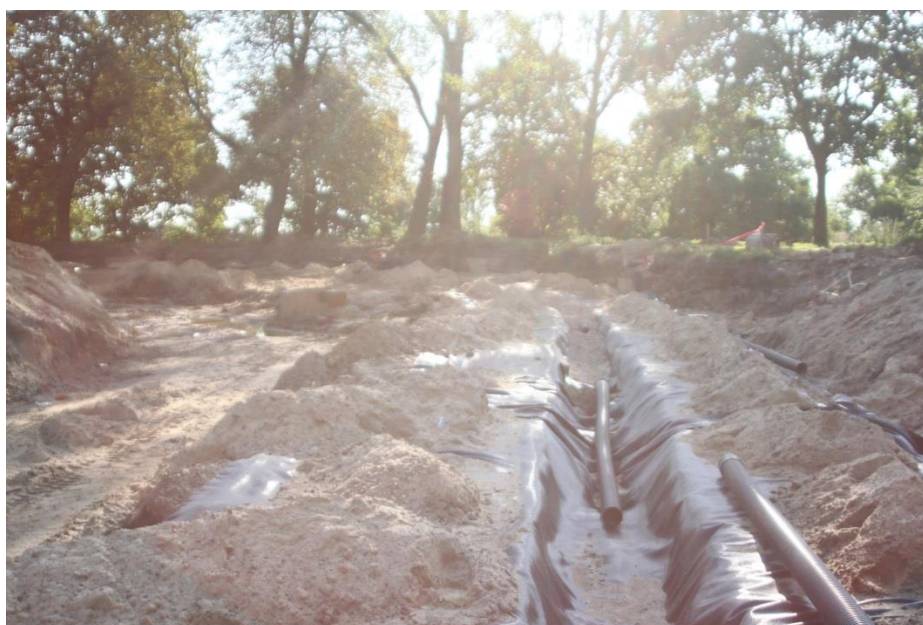
ul. Potulicka –teren pętli tramwajowej –sączki drenarskie
