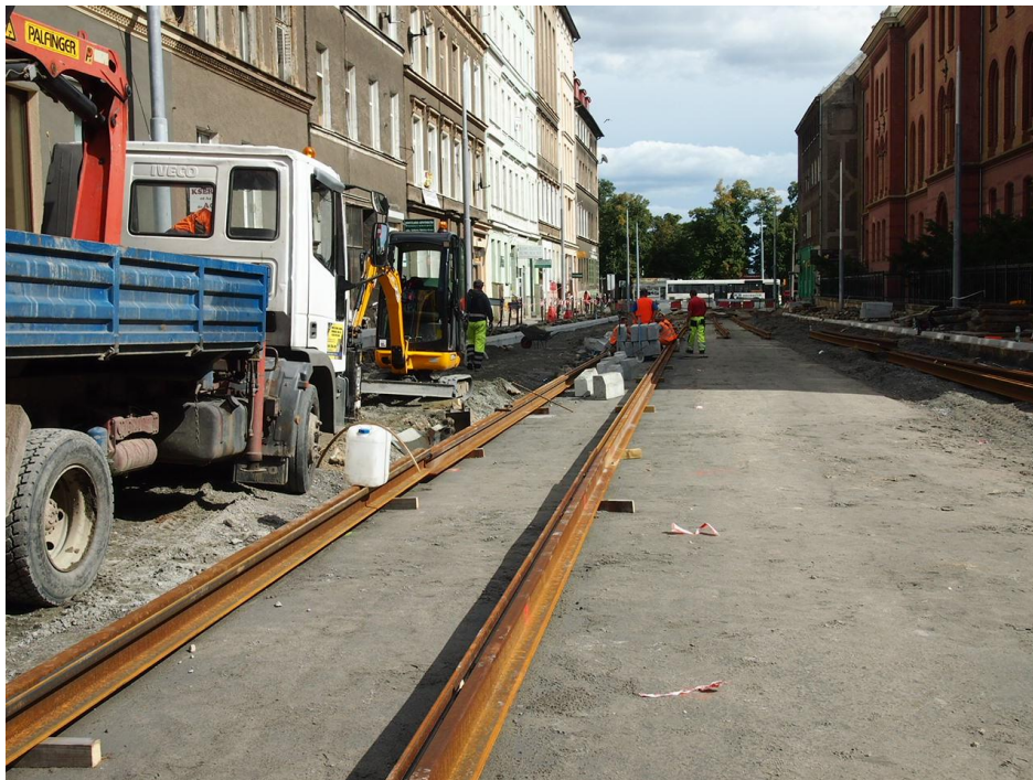
ul. Narutowicza – rozłożenie szyn na oczyszczonej warstwie stabilizacji
