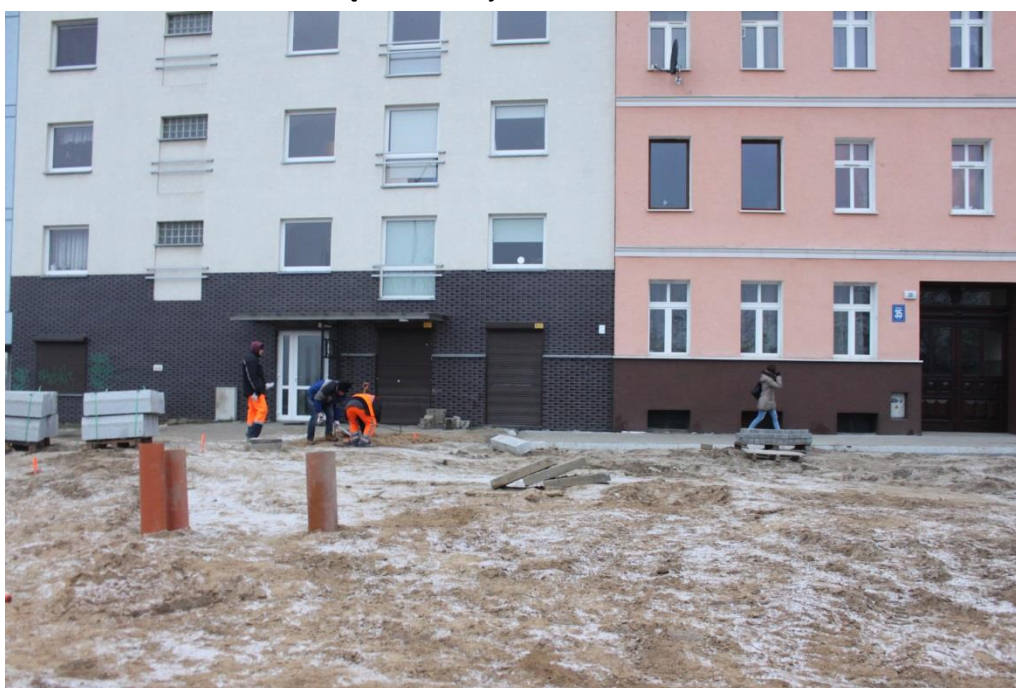
ul. Piekary – budowa chodnika
