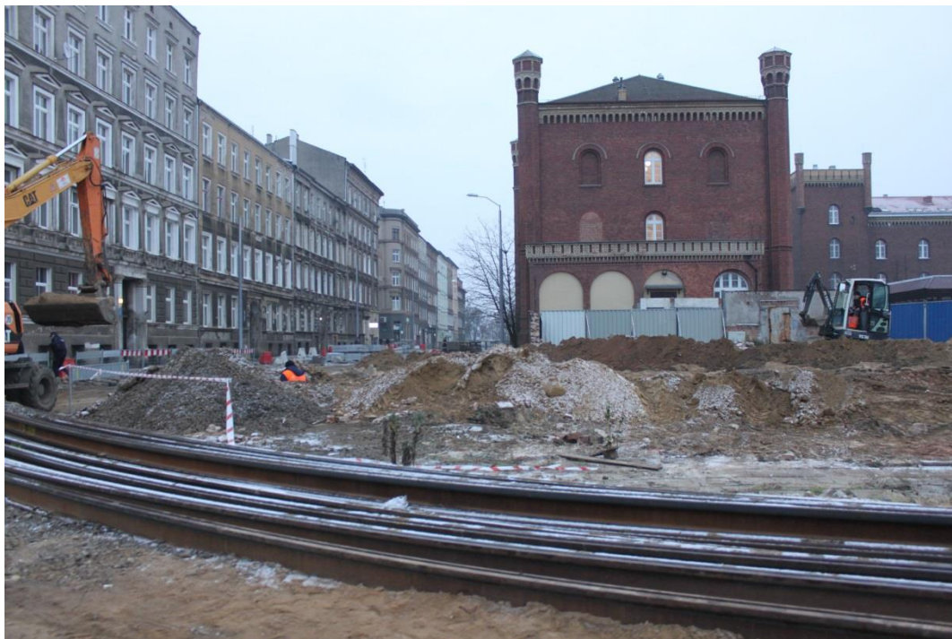
Skrzyżowanie ul. Potulickiej i Narutowicza – rozbiórka muru
