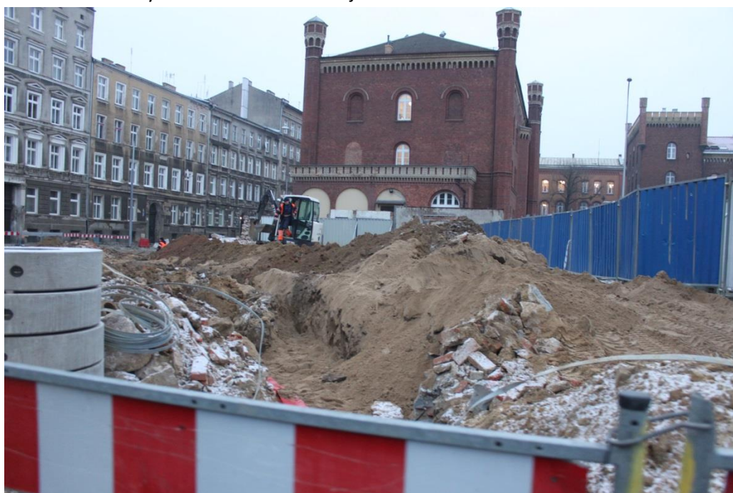
Skrzyżowanie ul. Potulickiej i Narutowicza – roboty elektryczne
