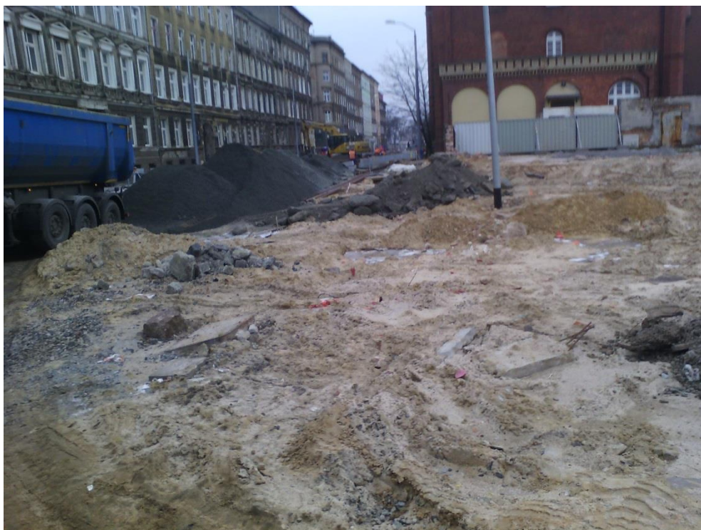
skrzyżowanie ul. Potulickiej z ul. Narutowicza
