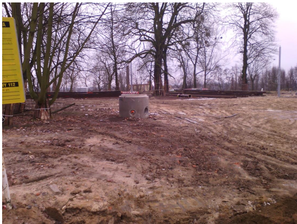
ul. Potulicka – teren pętli tramwajowej
