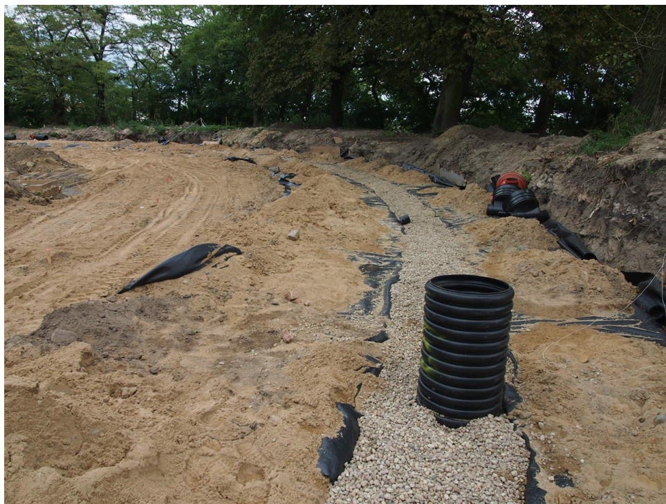
ul. Potulicka –teren pętli tramwajowej – uzupełnienie sączków drenarskich materiałem filtracyjnym
