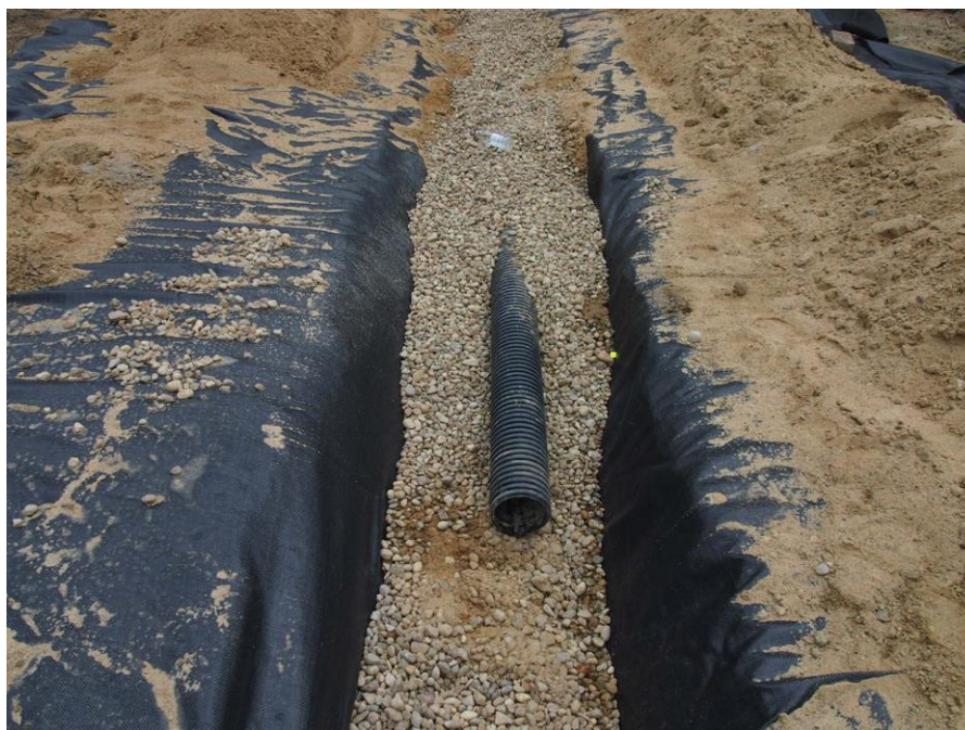
ul. Potulicka –teren pętli tramwajowej –sączki drenarskie
