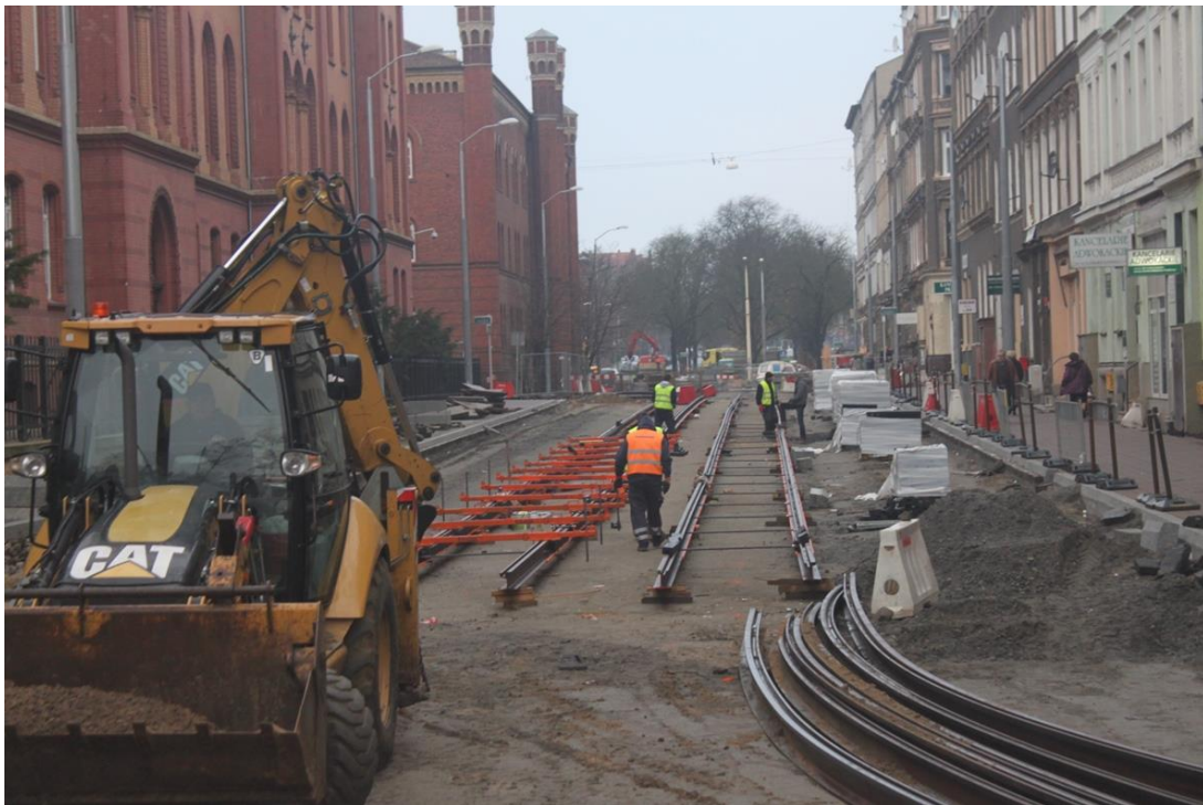
ul. Narutowicza, przygotowanie do montażu szyn
