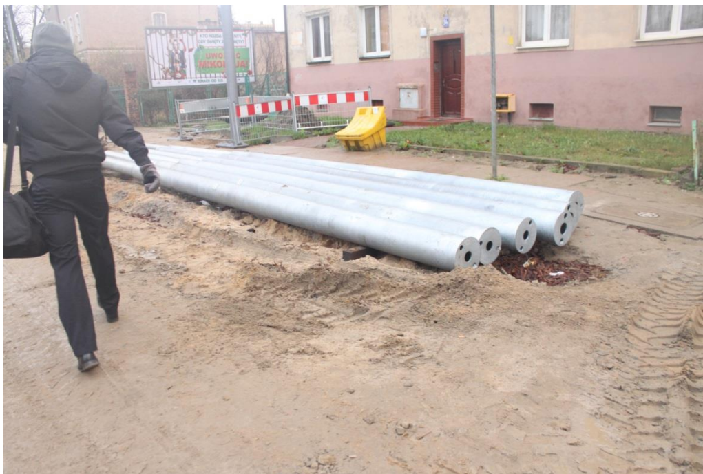
ul. Potulicka, przygotowanie do montażu słupów oświetleniowych
