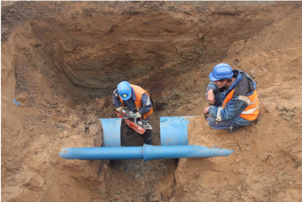
ul. Potulicka, naprawa wadliwego złącza na magistrali wodociągowej
