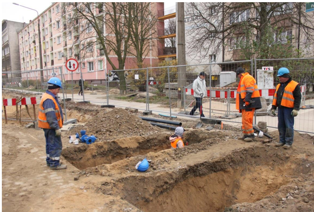
ul. Potulicka, uzupełnianie wykopów
