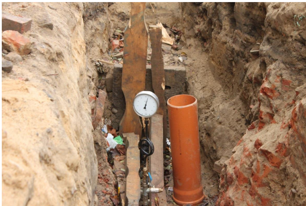
ul. Potulicka – Narutowicza, próba szczelności magistrali wodociągowej
