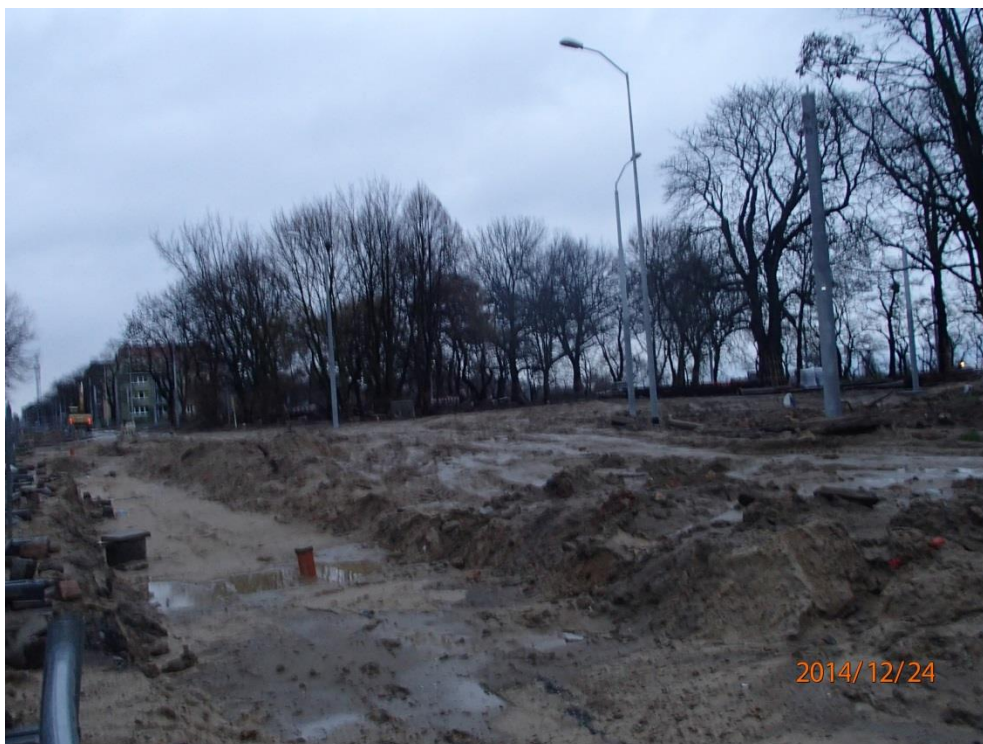
ul. Potulicka – teren pętli tramwajowej
