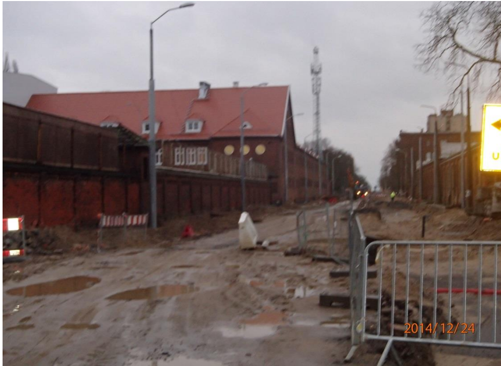
skrzyżowanie ul. Potulickiej z ul. Narutowicza
