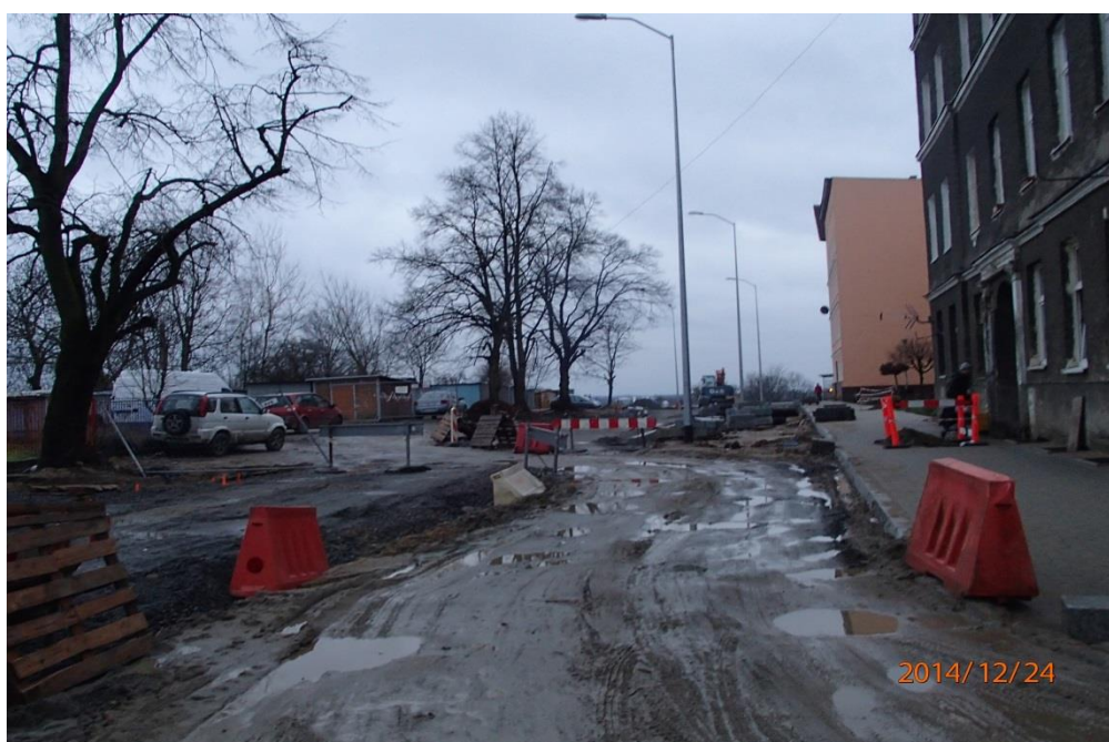
ul. Potulicka – roboty związane z układaniem chodnika
