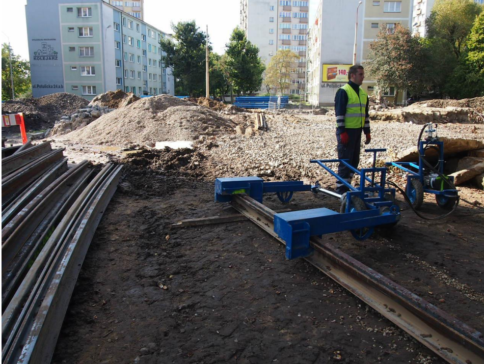
stanowisko gięcia szyn do promieni zgodnie z projektem
