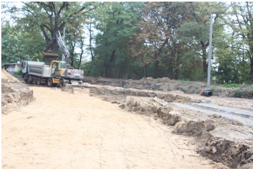
ul. Potulicka – korytowanie pod torowisko na terenie pętli tramwajowej
