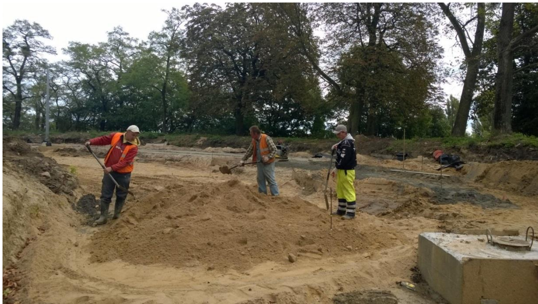
ul. Potulicka –plantowanie zasypki pod ułożenie konstrukcji torowiska na pętli tramwajowej
