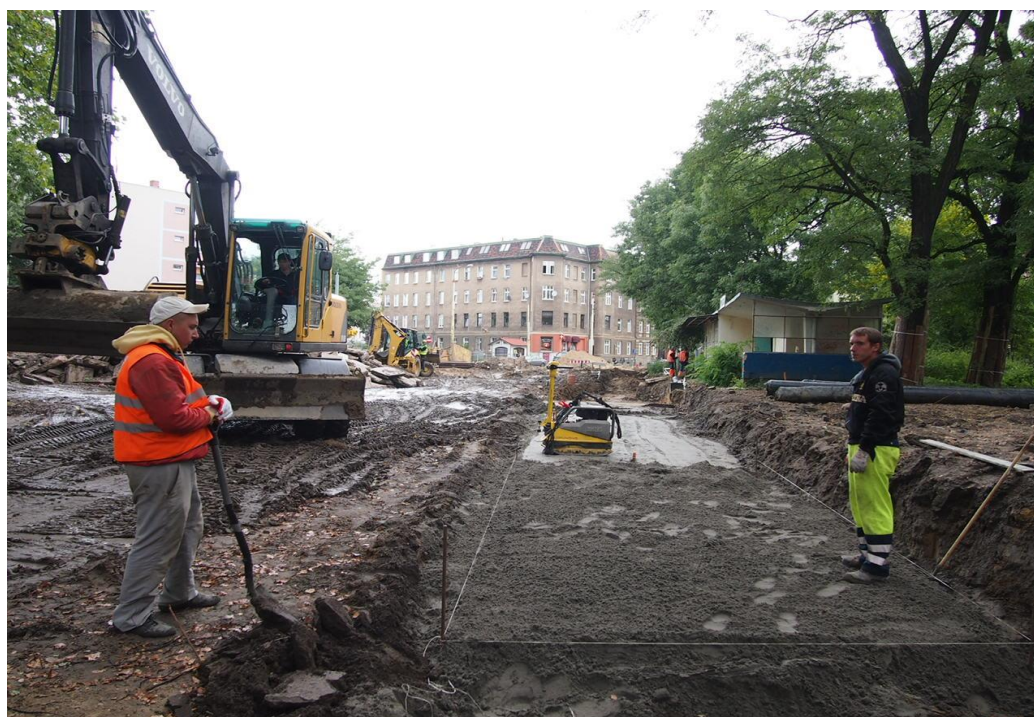
ul. Potulicka – plantowanie terenu – przygotowanie koryta torowiska na terenie pętli tramwajowej
