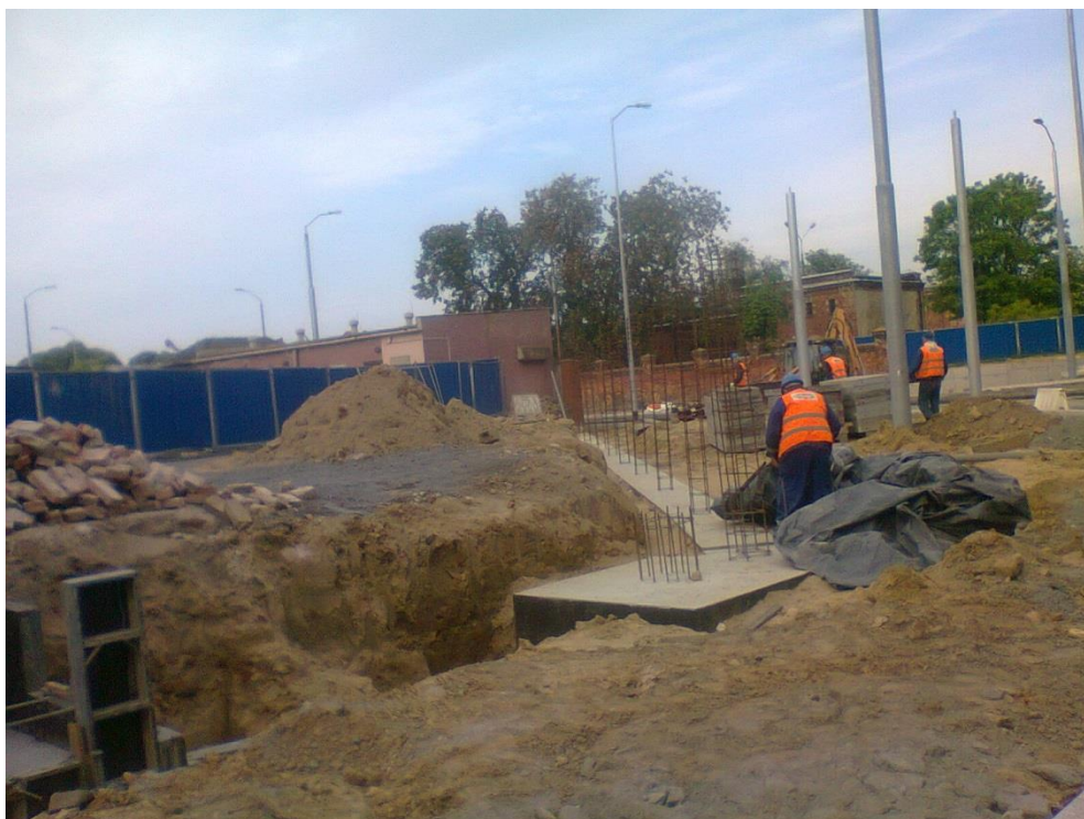
skrzyżowanie ul. Narutowicza z ul. Potulicką
