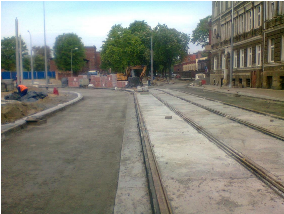
skrzyżowanie ul. Narutowicza z ul. Potulicką
