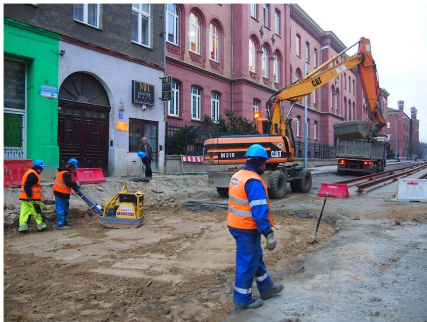
Zagęszczenie koryta torowiska i jezdni
