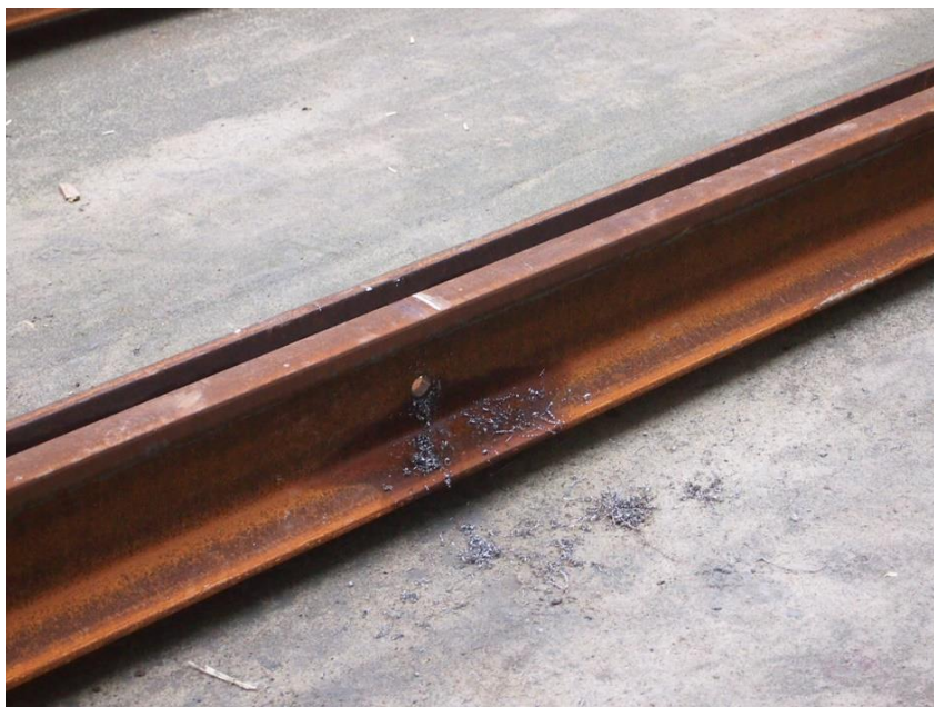
Przygotowanie szyn do montażu poprzeczek torowych
