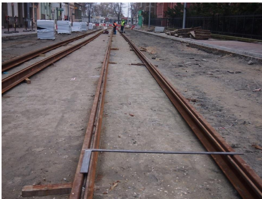
Regulacja położenia szyn na torowisku przy ul. Narutowicza
