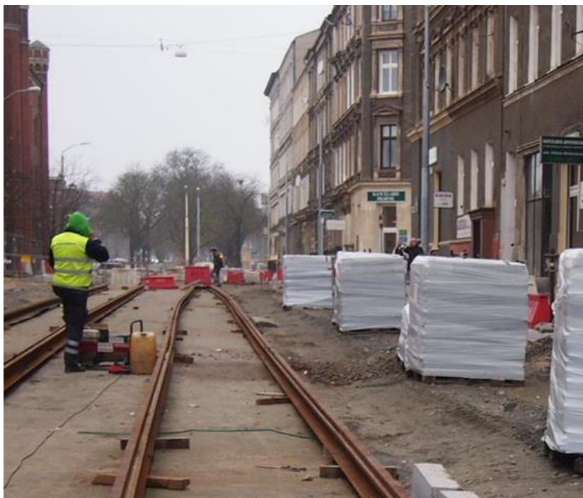
Oczyszczenie powierzchni stalowej szyny przy ul. Narutowicza
