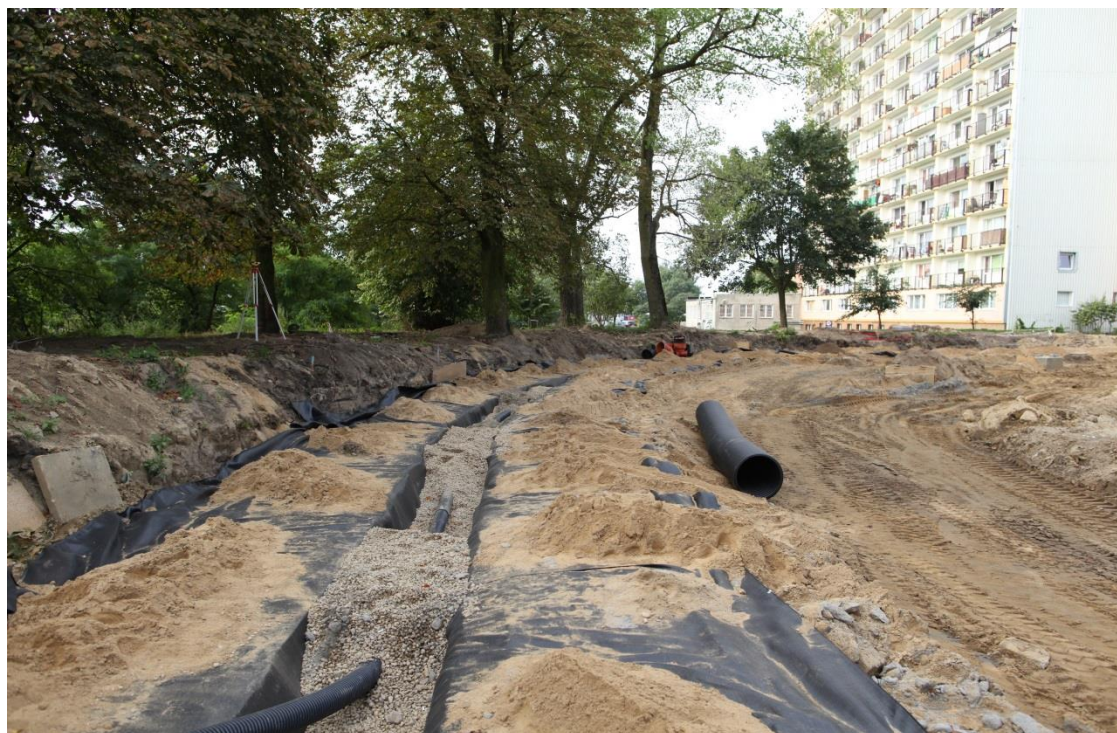
ul. Potulicka –teren pętli tramwajowej – prace związane z drenażem
