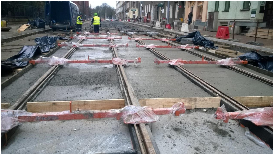
Betonowanie górnej płyty torowiska oraz jej zabezpieczenie po zakończeniu betonowania ul. Narutowicza
