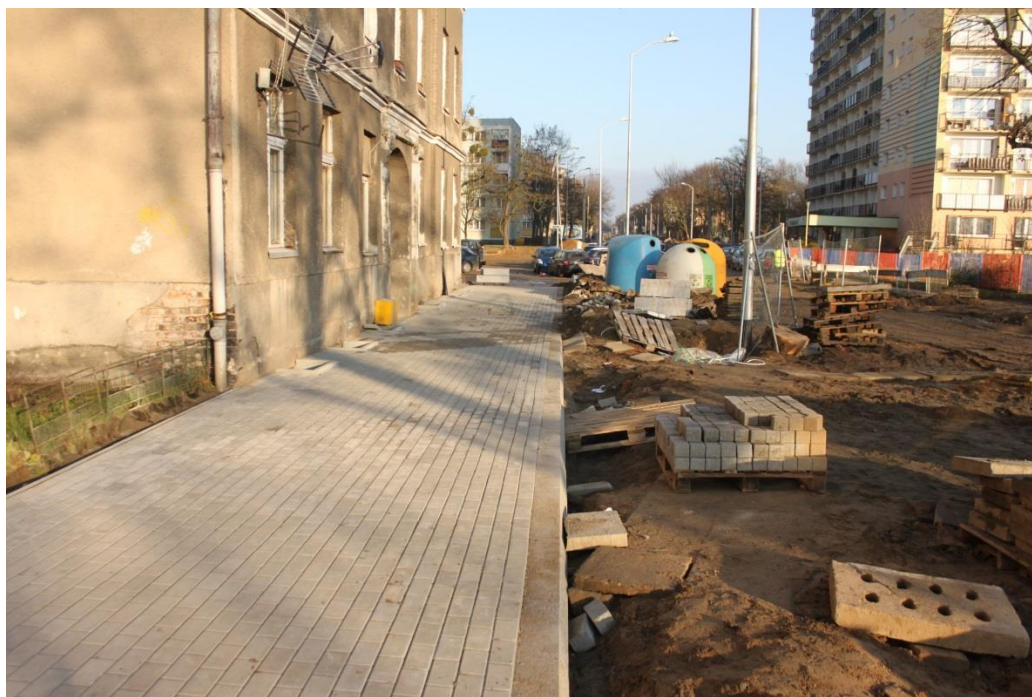
ul. Potulicka – roboty związane z układaniem chodnika
