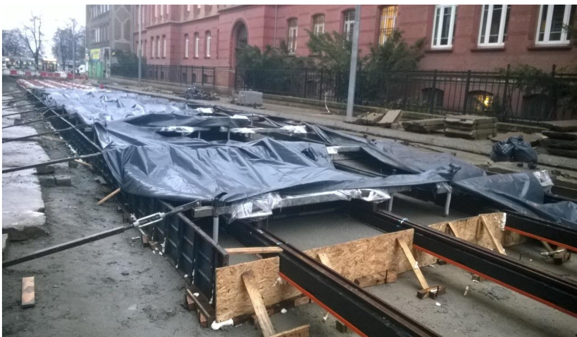
Betonowanie górnej płyty torowiska oraz jej zabezpieczenie po zakończeniu betonowania ul. Narutowicza
