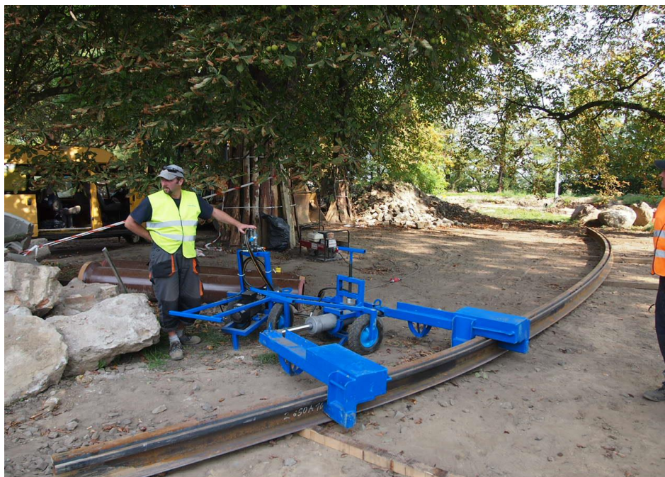
stanowisko gięcia szyn do promieni zgodnie z projektem
