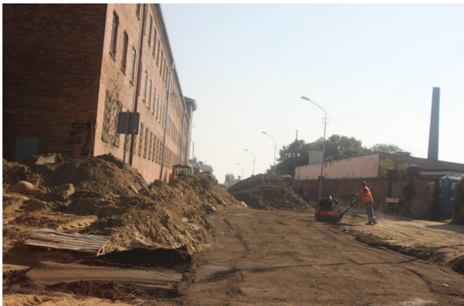
ul. Czarnieckiego – przygotowanie nawierzchni do poprowadzenia przejazdu tymczasowego
