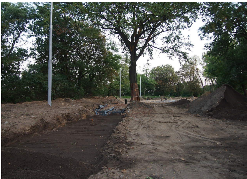
ul. Potulicka –plantowanie terenu – przygotowanie koryta torowiska na terenie pętli tramwajowej
