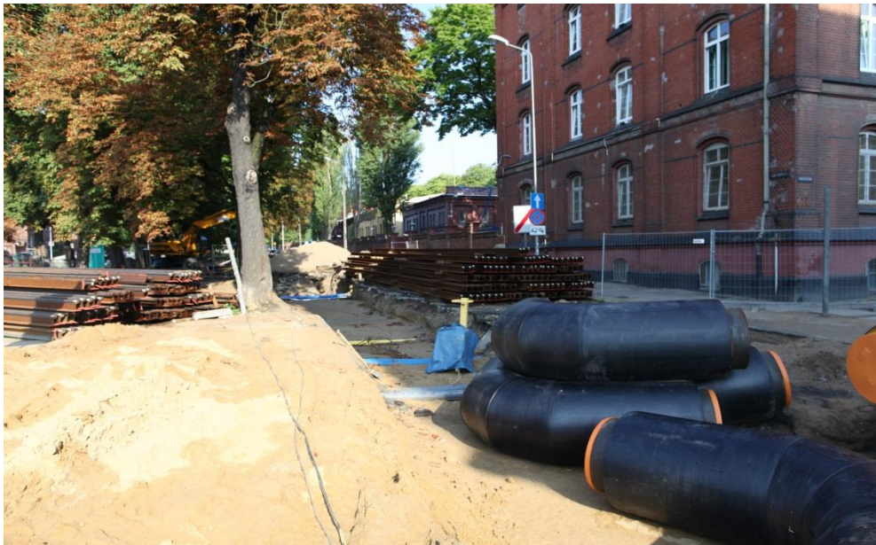
ul. Narutowicza – prace SEC
