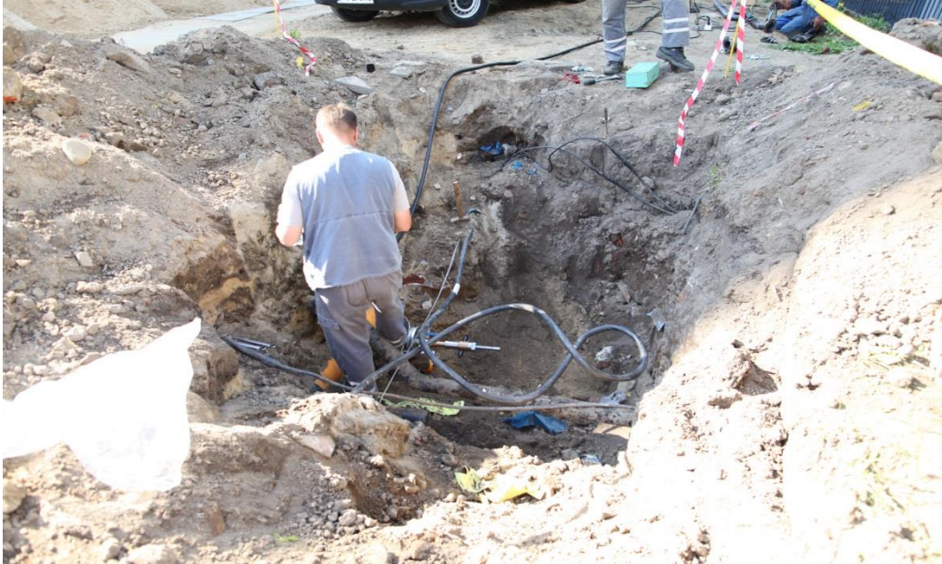
ul. Potulicka – prace przy przyłączeniach budynków do gazociągu
