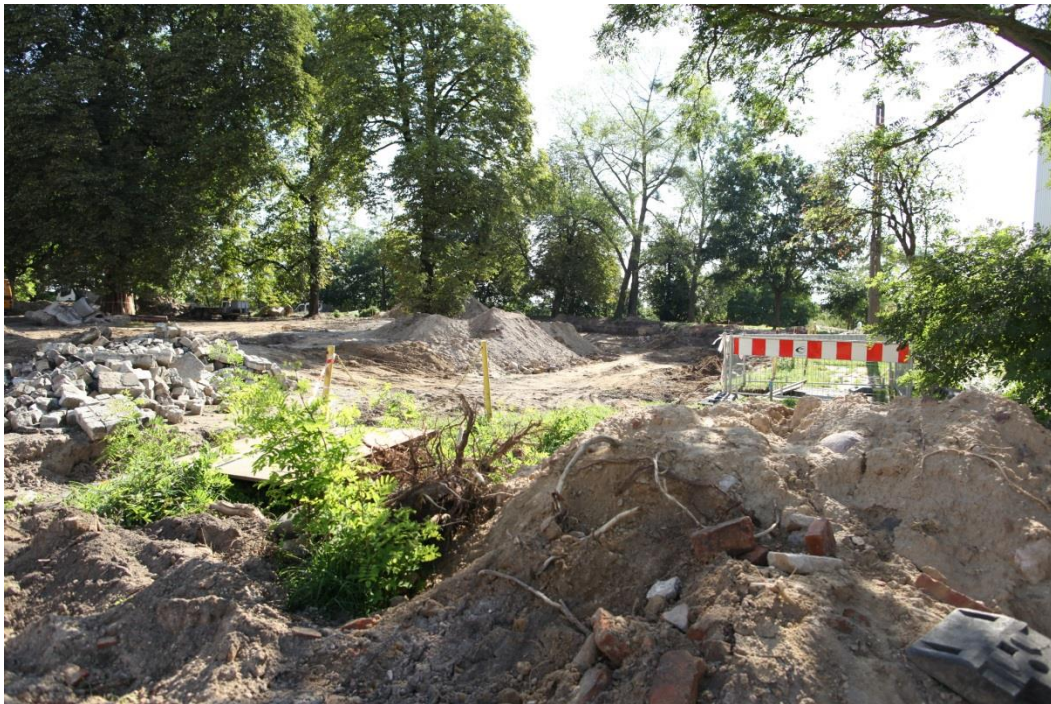
ul. Potulicka –teren pętli tramwajowej
