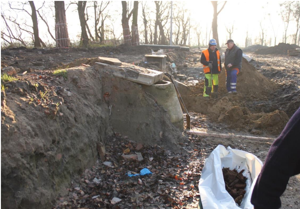
Pętla tramwajowa na ul. Potulickiej
