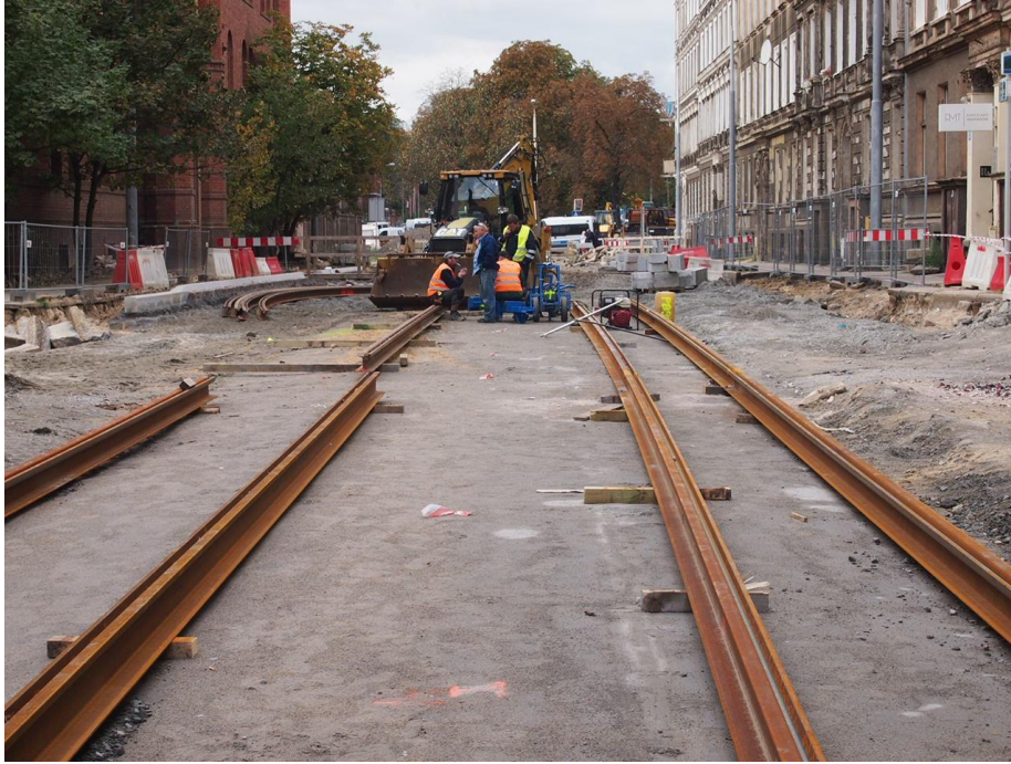
ul. Narutowicza – przygotowanie do układania szyn w miejscu projektowanego torowiska
