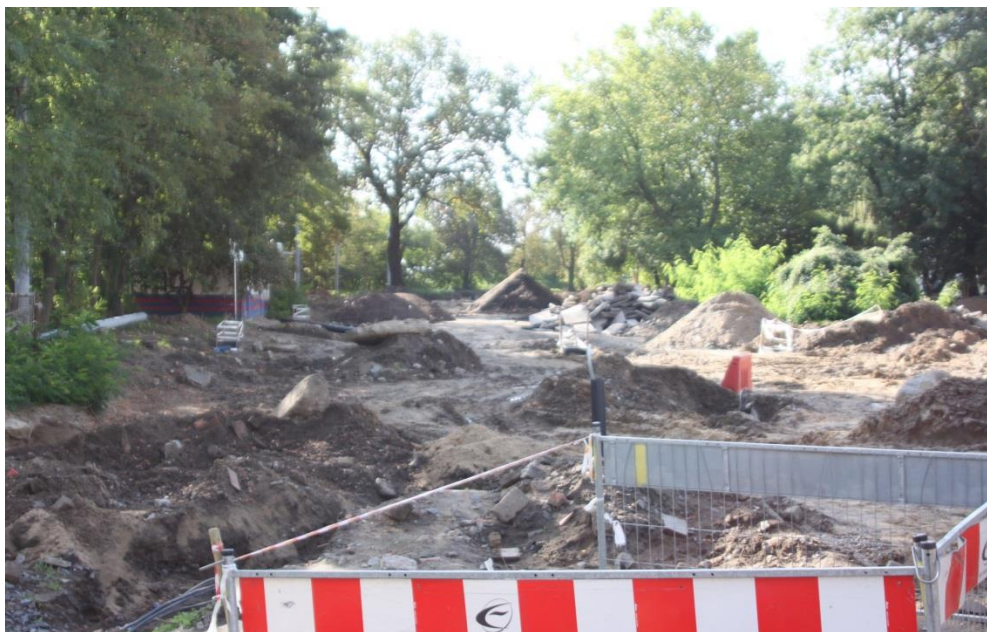
ul. Potulicka –teren pętli tramwajowej
