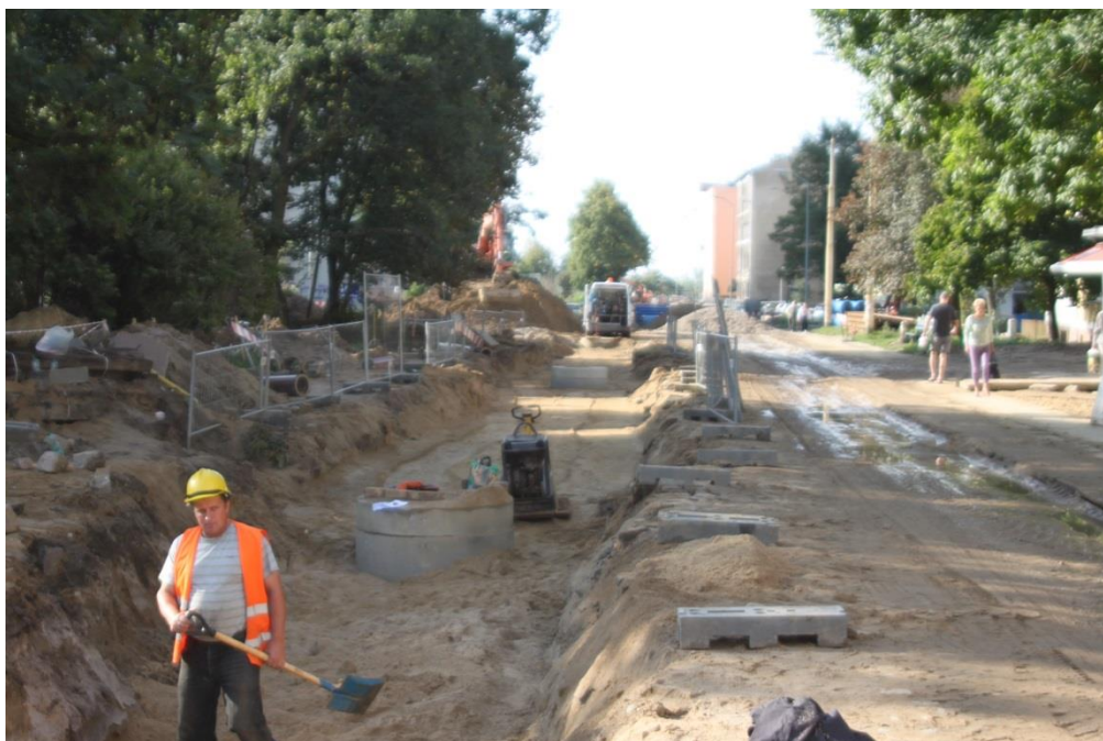
ul. Potulicka – zagęszczanie gruntu w wykopie pod kanalizację sanitarną
