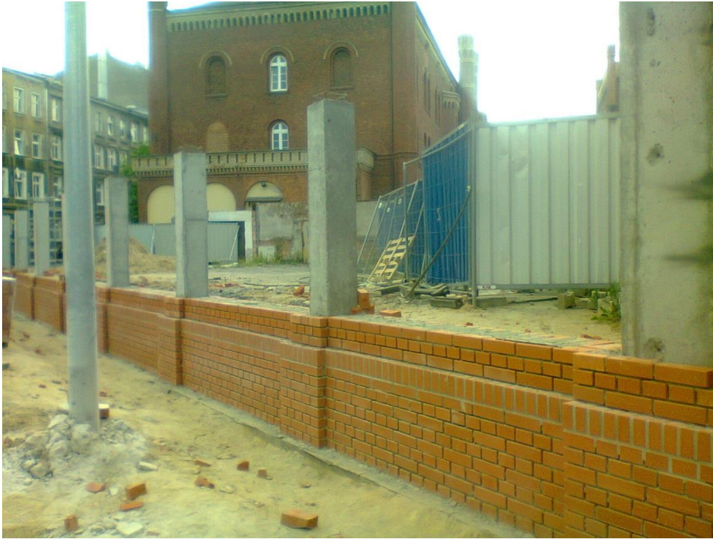
skrzyżowanie ul. Narutowicza z ul. Potulicką
