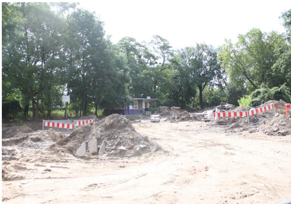
ul. Potulicka –pętla tramwajowa –zabetonowane stopy pod słupy trakcyjne
