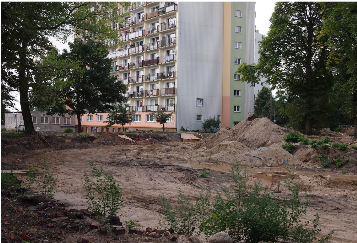
ul. Potulicka –pętla tramwajowa –zabetonowane stopy pod słupy trakcyjne
