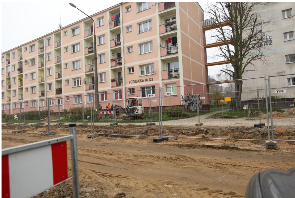
ul. Potulicka – wykopy pod fundamenty słupów trakcyjnych
