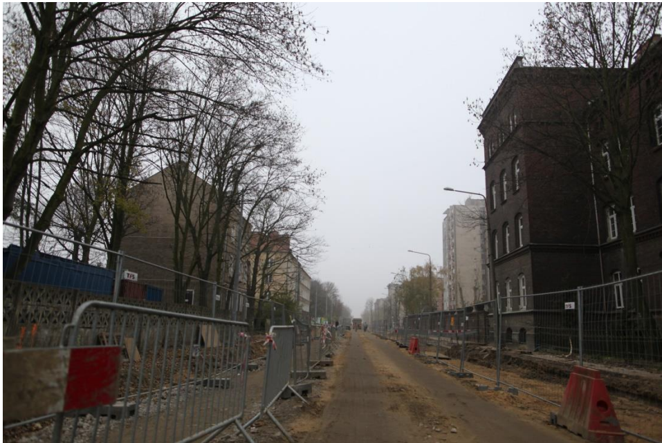
ul. Potulicka – droga tymczasowa z wydzielonym ciągiem pieszym
