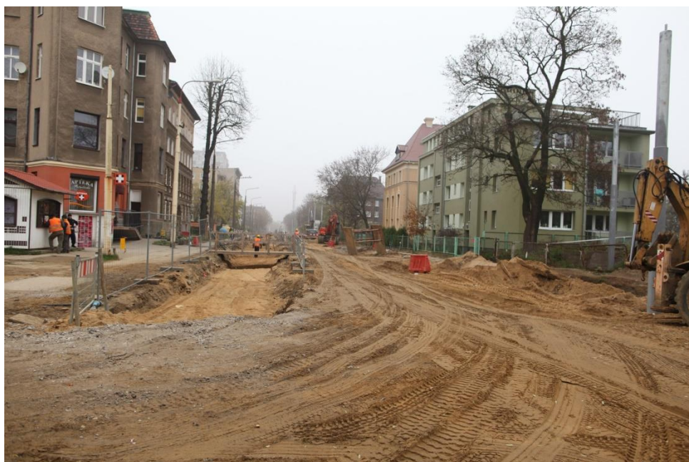
ul. Potulicka – zasypanie magistrali wodociągowej
