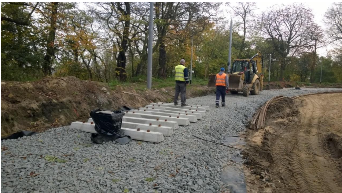
Pętla tramwajowa przy ul. Potulickiej – przygotowanie do rozłożenia podkładów strunobetonowych
