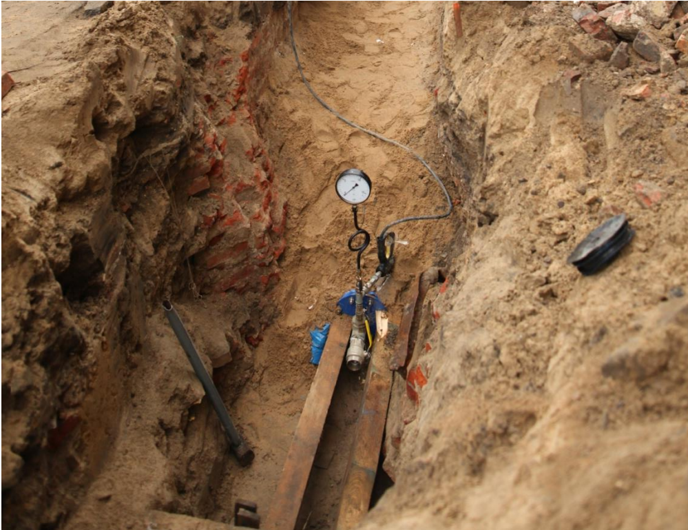
Odcinek Piekary – Osiedle Pionierów - próba szczelności
