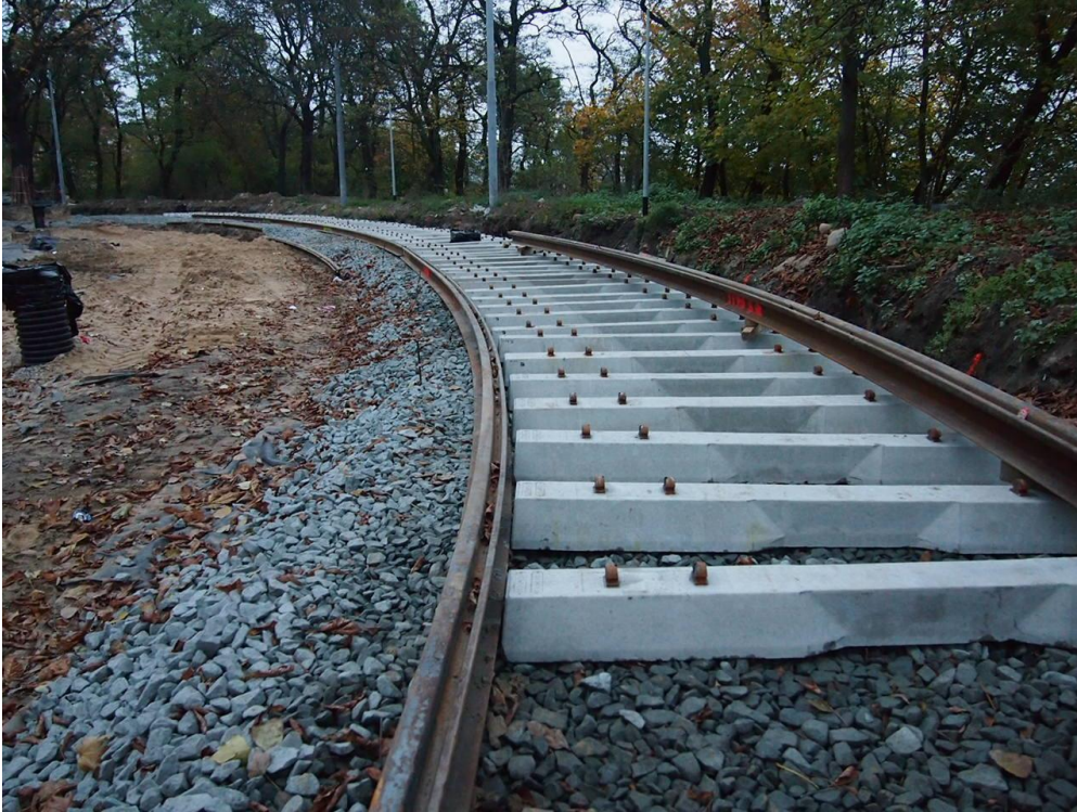
Pętla tramwajowa przy ul.Potulickiej – przygotowanie do montażu szyn
