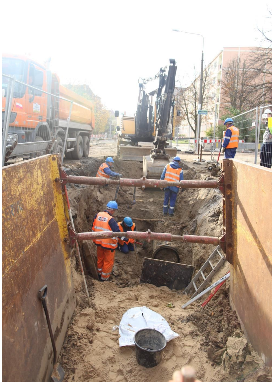
Skrzyżowanie z ul. Sowińskiego – budowa magistrali wodociągowej
