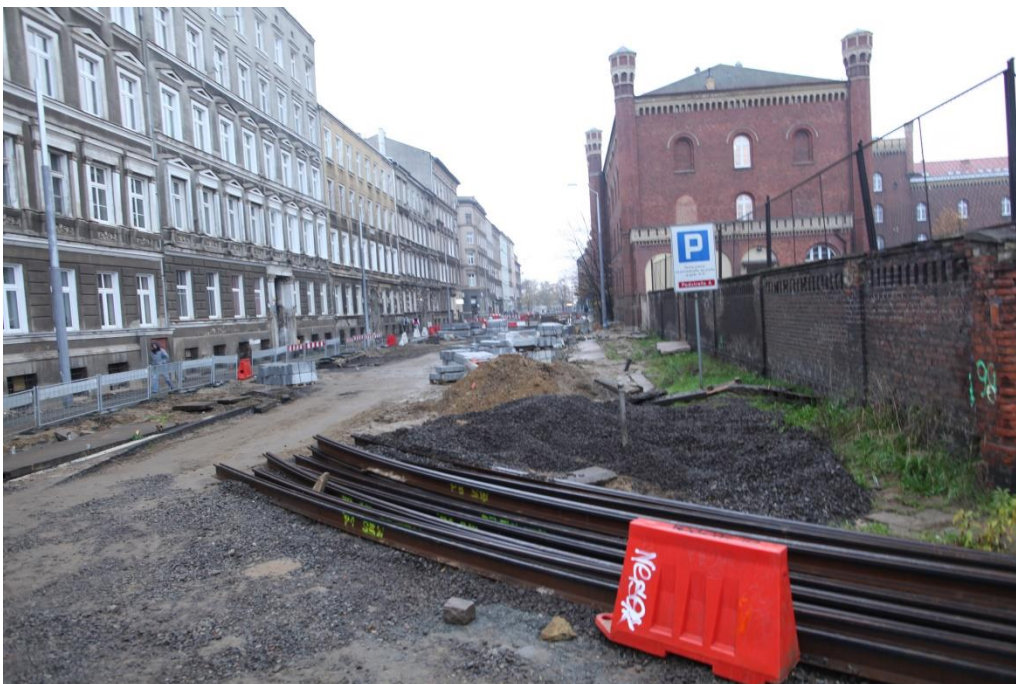
Pętla tramwajowa przy ul.Potulickiej – przygotowanie do montażu szyn
