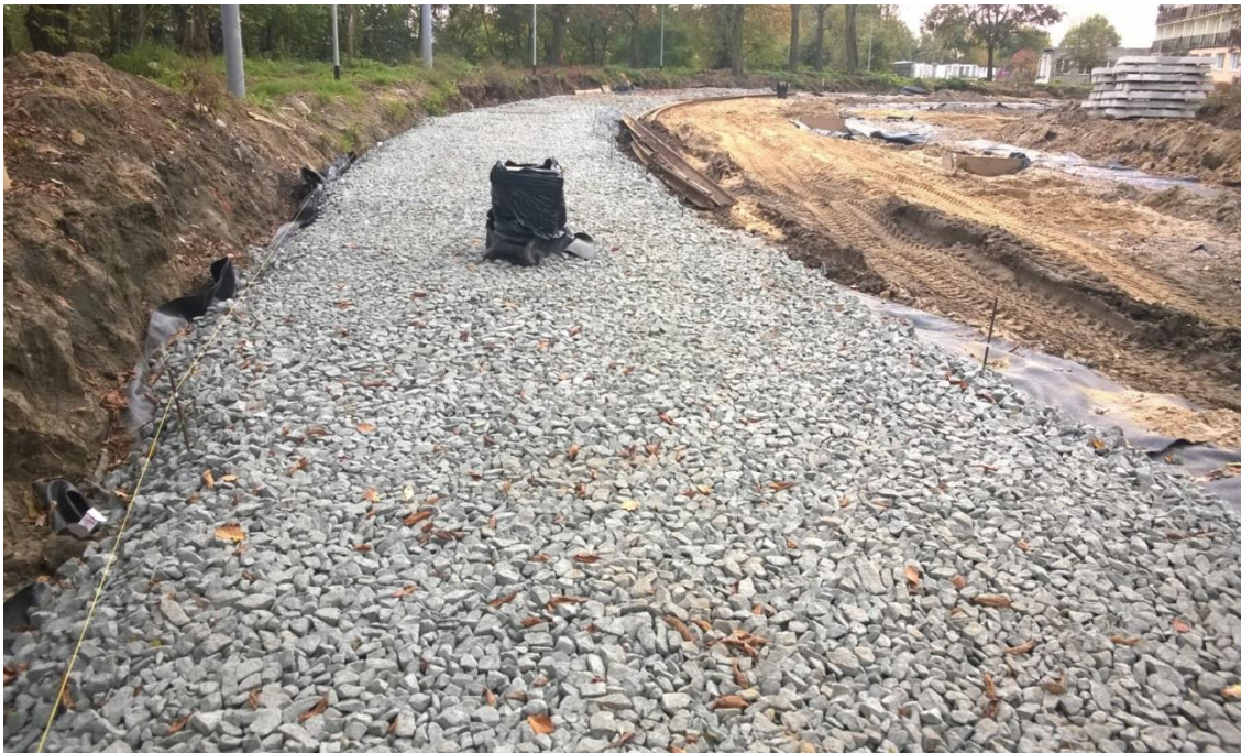
ul. Potulicka – rozłożenie podbudowy tłuczniowej na torowisk na terenie pętli tramwajowej, przygotowanie do badania nośności dla toru 1
