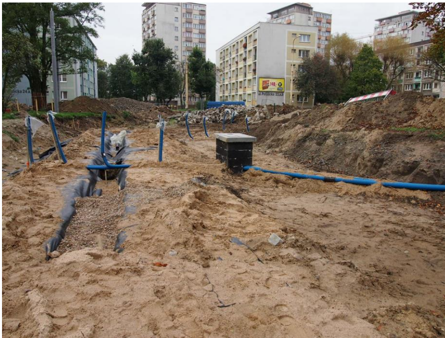
ul. Potulicka – podłączenie odwodnienia przyszynowego na terenie pętli tramwajowej
