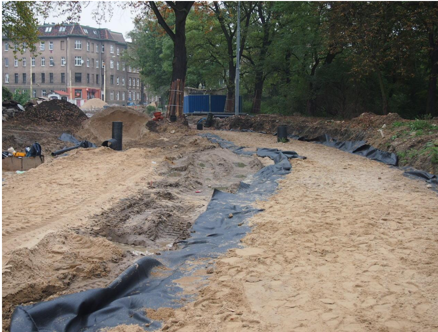
ul. Potulicka – przygotowanie warstwy podsypki na geotkaninie pod warstwę tłuczniovą torowiska
