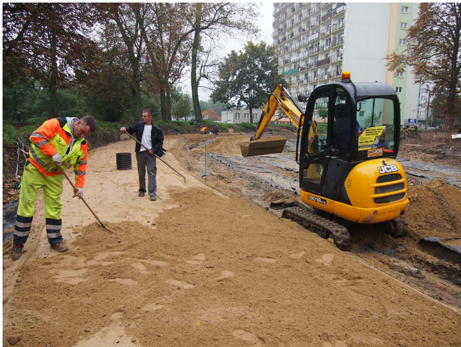
ul. Potulicka – warstwa odsączająca dla toru 1 na terenie pętli tramwajowej
