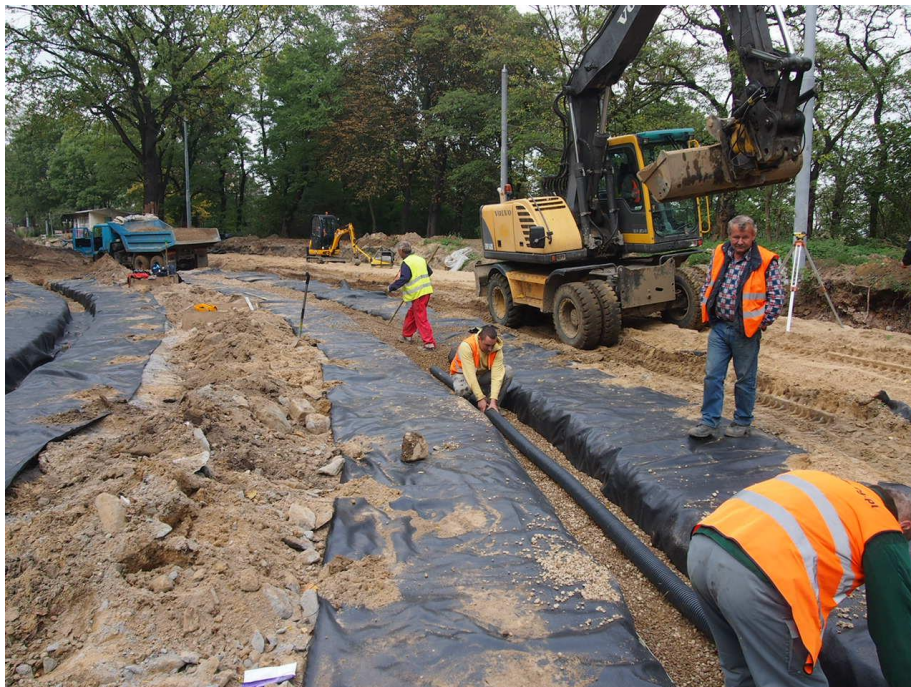
ul. Potulicka – ułożenie sączków drenarskich w torowisku na pętli tramwajowej
