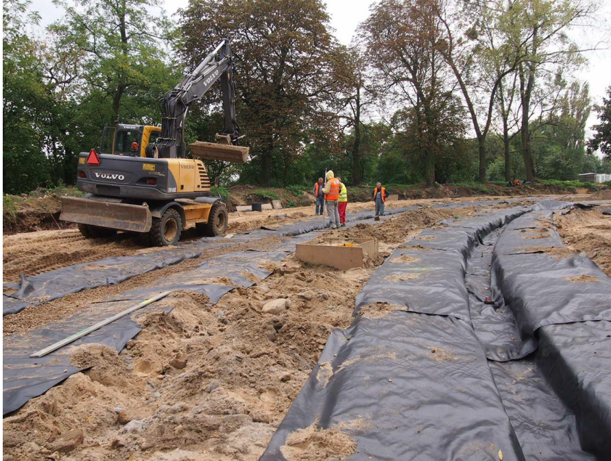
ul. Potulicka – ułożenie geowłókniny wzmacniającej konstrukcję torowiska na pętli tramwajowej
