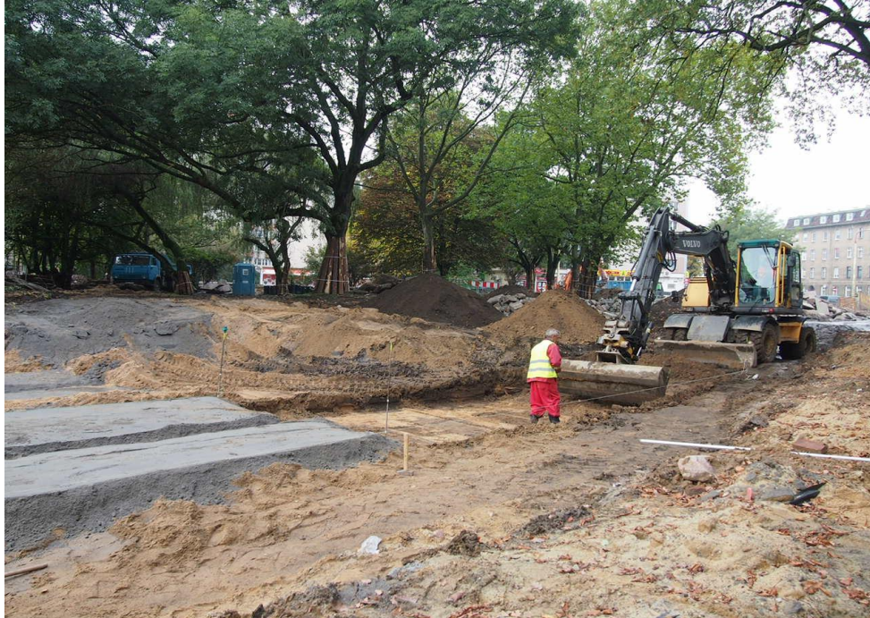
ul. Potulicka – konstrukcja pod perony przystankowe na terenie pętli tramwajowej
