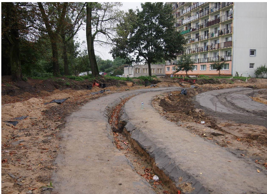
ul. Potulicka – przygotowanie terenu – wzmocnienie koryta torowiska na terenie pętli tramwajowej
