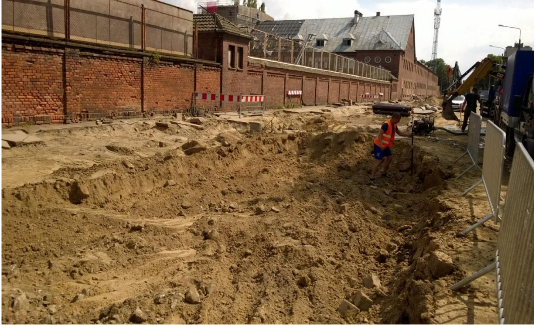
ul. Potulicka – wykonywanie koryta jezdni i torowiska
