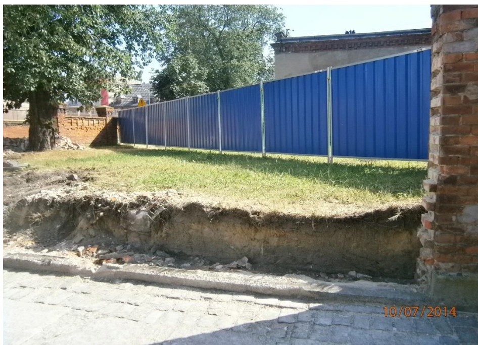
rozbiórka ogrodzenia na terenie jednostki Wojska Polskiego
