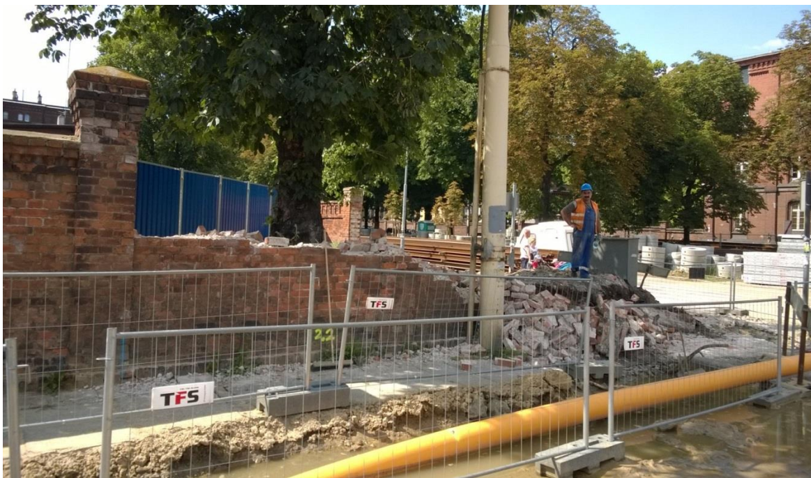
rozbiórka ogrodzenia na terenie jednostki Wojska Polskiego
