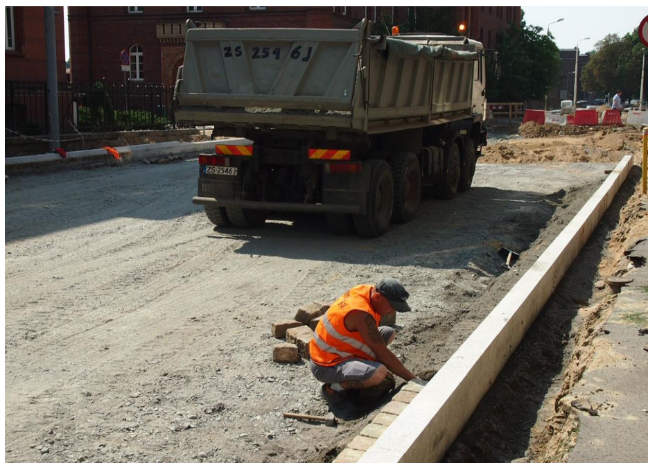
ul. Narutowicza – ustawianie krawężników
