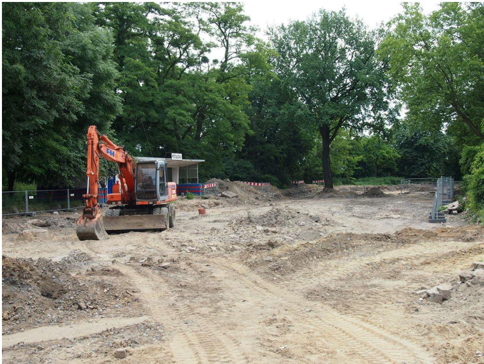
ul. Potulicka - roboty ziemne na pętli tramwajowej;
