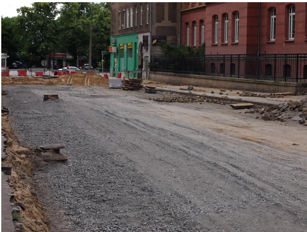
ul.Narutowicza – wykonywanie podbudowy z tłucznia;
