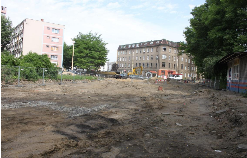
ul. Potulicka – teren pętli tramwajowej
