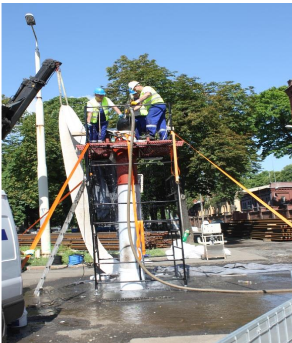
roboty renowacyjne na kanale ogólnospławnym w ul. Narutowicza
