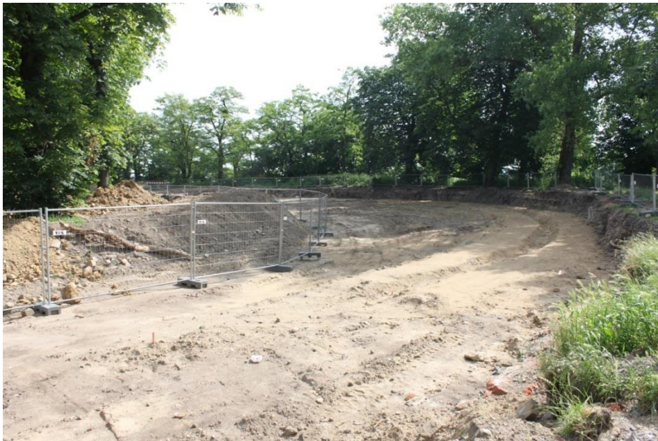
ul. Potulicka – teren pętli tramwajowej
