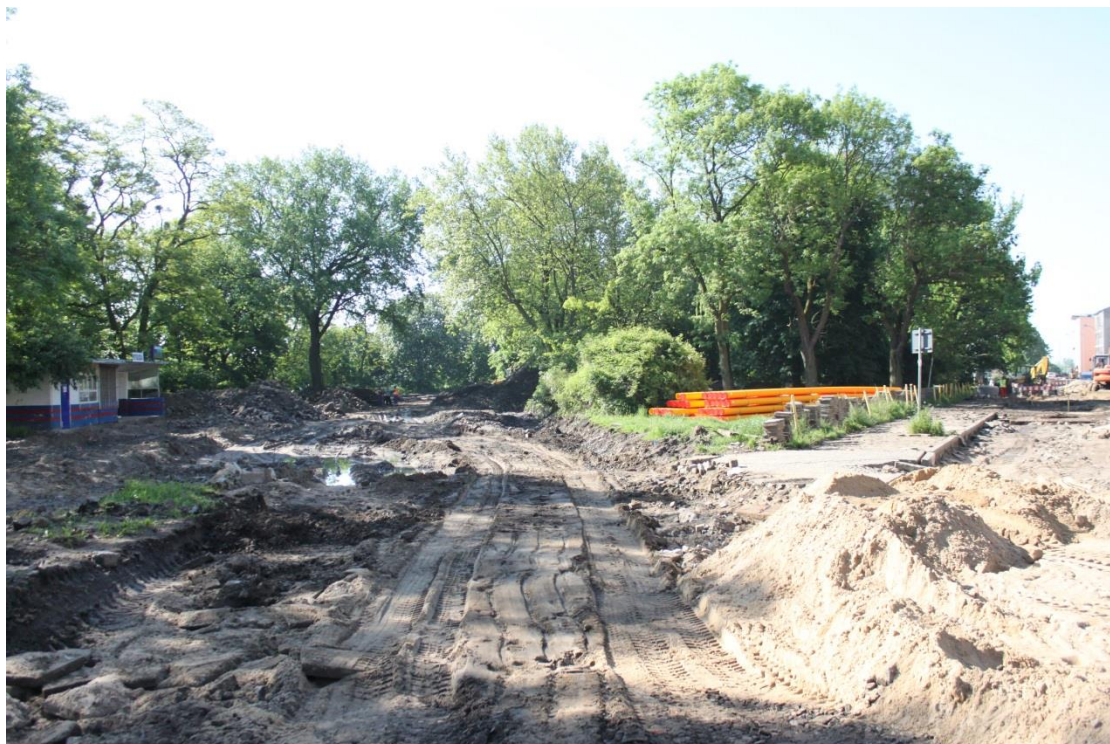
ul. Potulicka – teren po pętli tramwajowej
