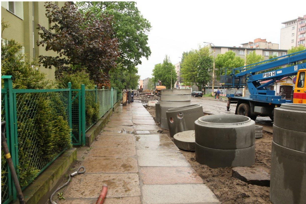
ul. Potulicka – roboty ziemne
