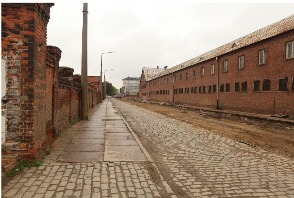
ul. Potulicka – roboty rozbiórkowe
