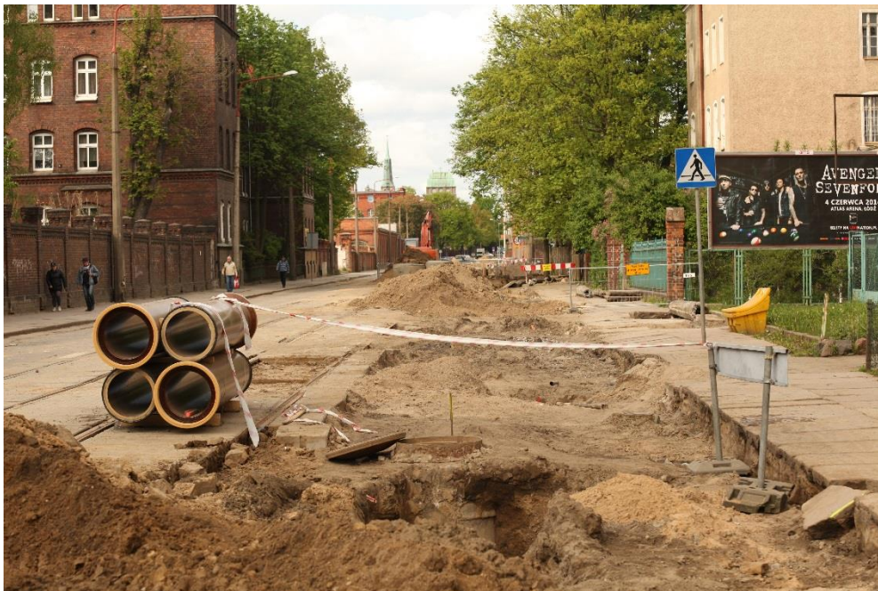
ul. Potulicka – w trakcie robót kanalizacyjnych
