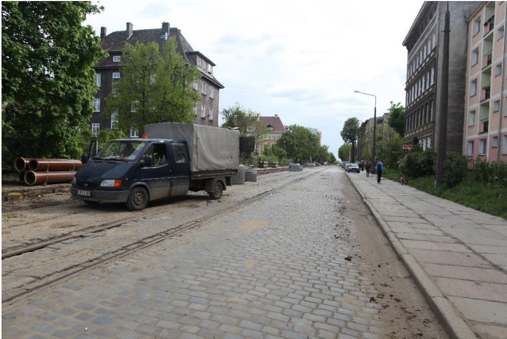
ul. Potulicka – roboty kanalizacyjne
