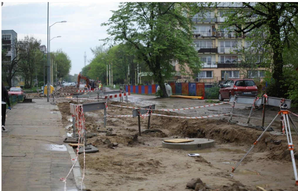
ul. Potulicka – roboty ziemne
