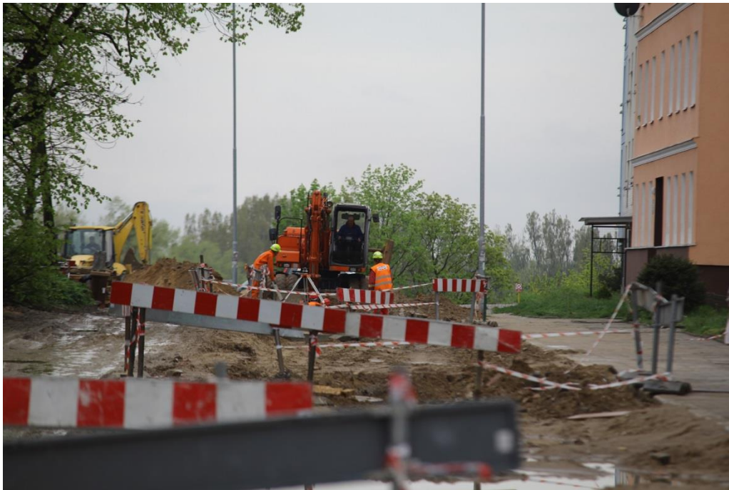
ul. Potulicka – roboty ziemne
