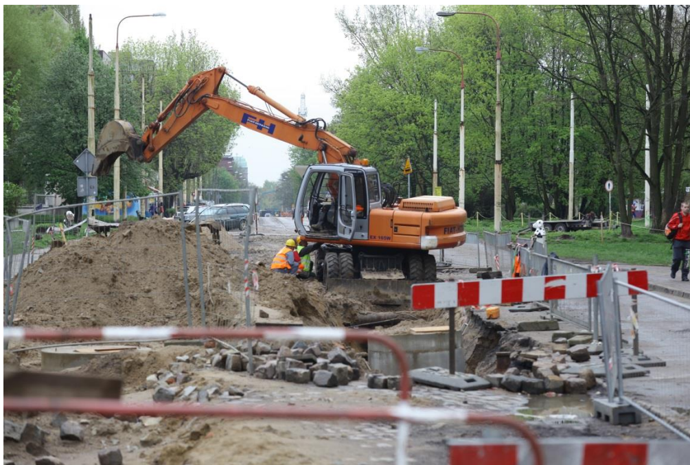
ul. Potulicka – roboty ziemne
