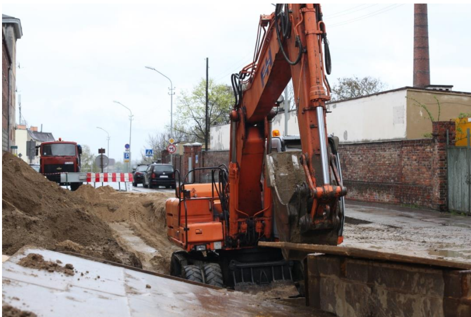
ul. Hetmana Czarnieckiego –roboty ziemne, kanalizacja
