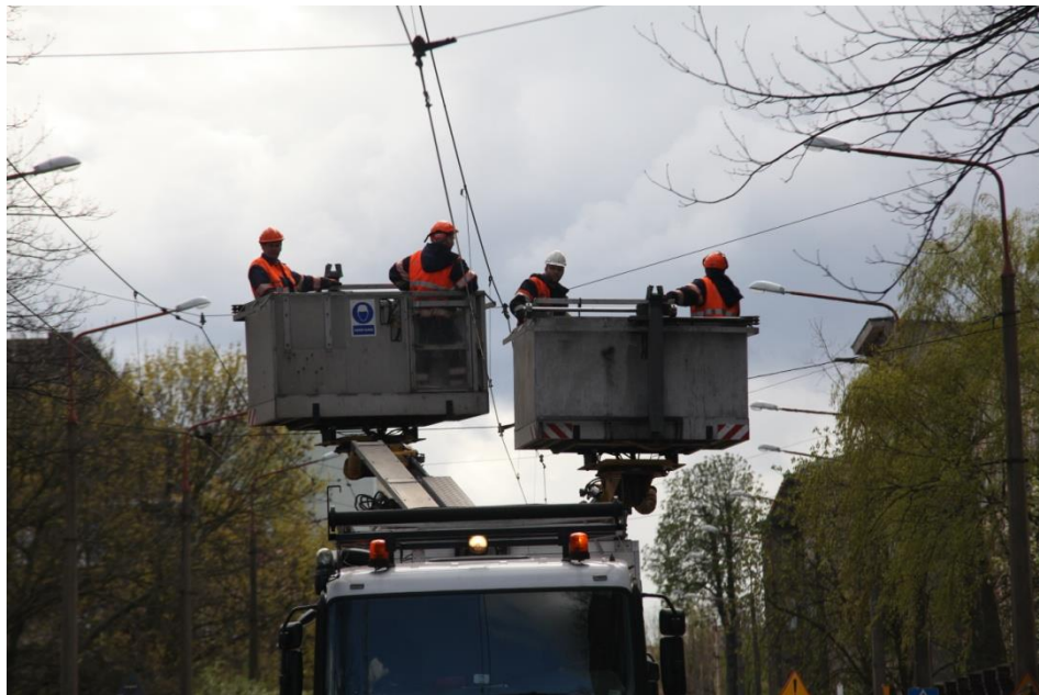
ul. Potulicka –demontaż trakcji tramwajowej
