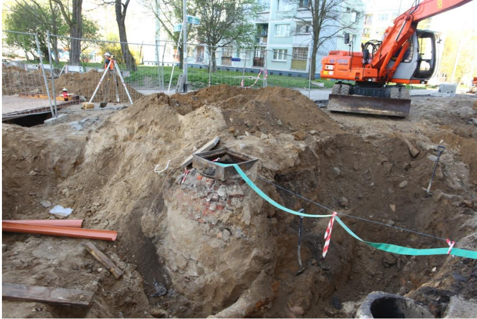
skrzyżowanie ul. Piekary z ul. Potulicką – wykonane prace ziemne
