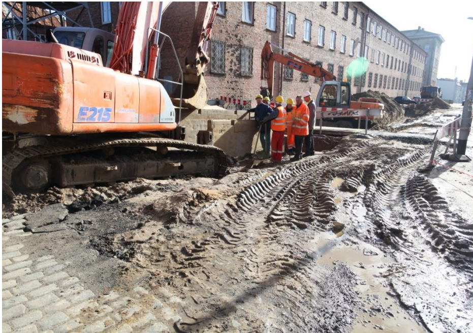
ul. Hetmana Czarnieckiego –roboty ziemne, kanalizacja
