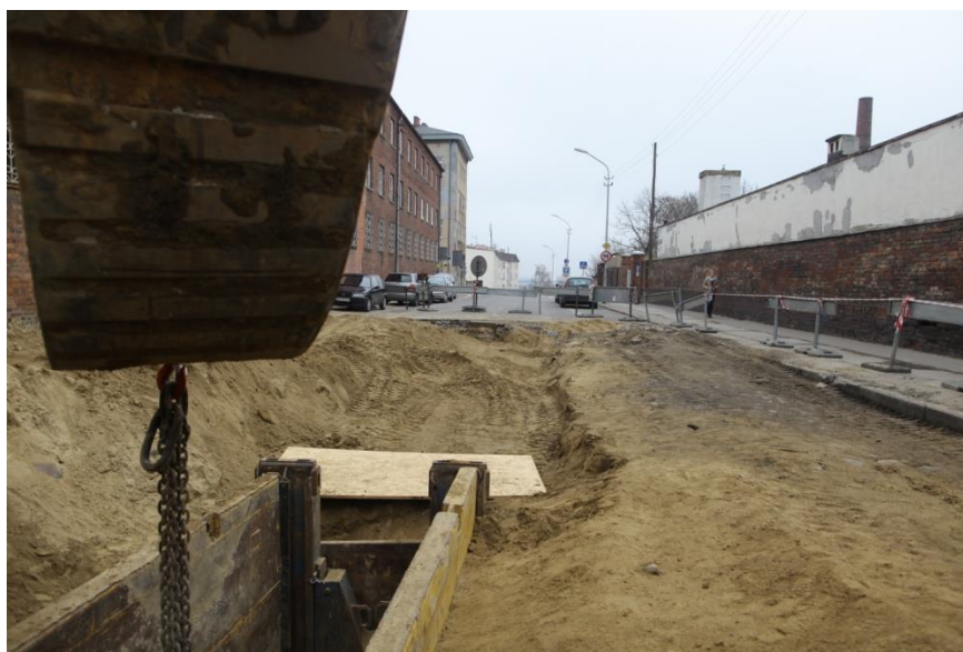
Ul. Hetmana Czarnieckiego –roboty ziemne, kanalizacja
