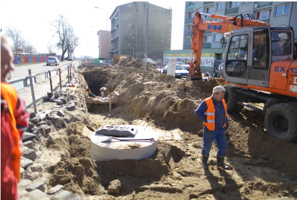
ul. Potulicka – roboty ziemne
