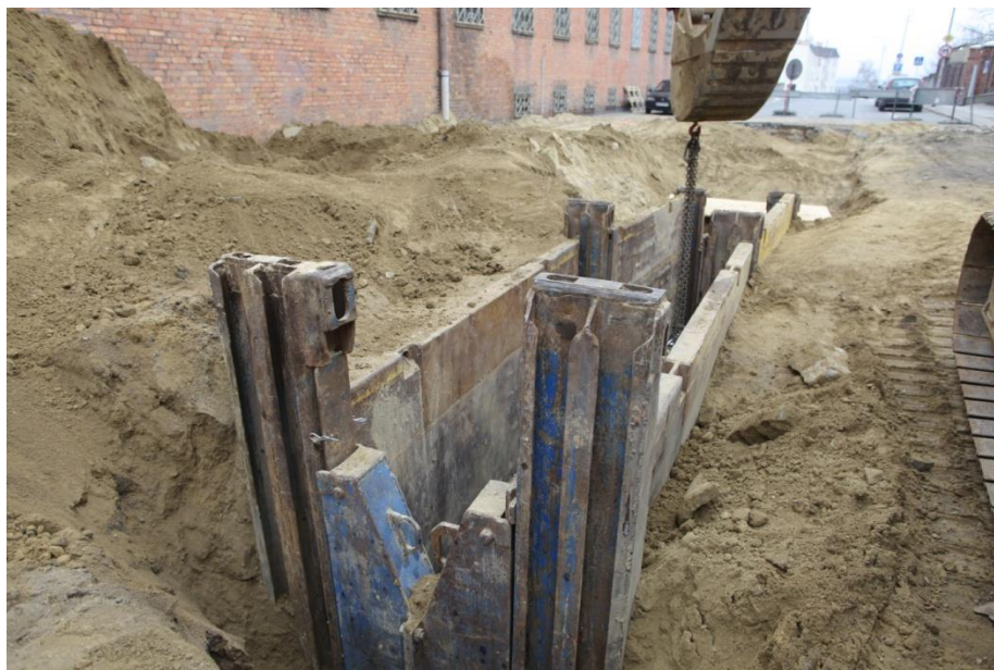
Ul. Hetmana Czarnieckiego –roboty ziemne, kanalizacja
