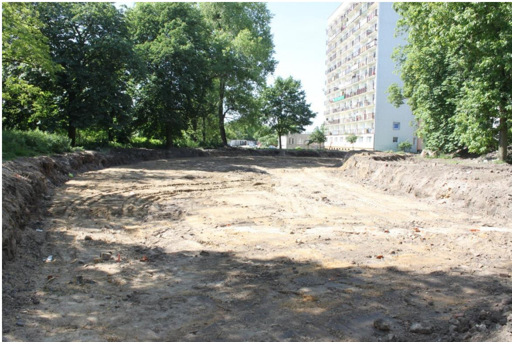
ul. Potulicka – teren pętli tramwajowej
